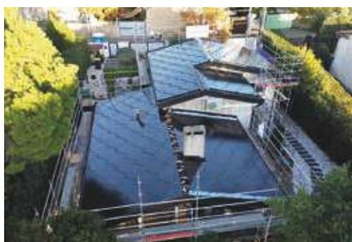
Toiture avec tuiles photovoltaïques.
