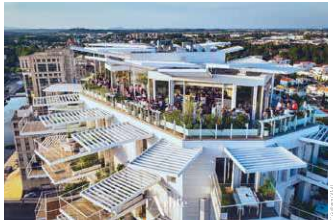
Rooftop Arbre Blanc Montpellier
